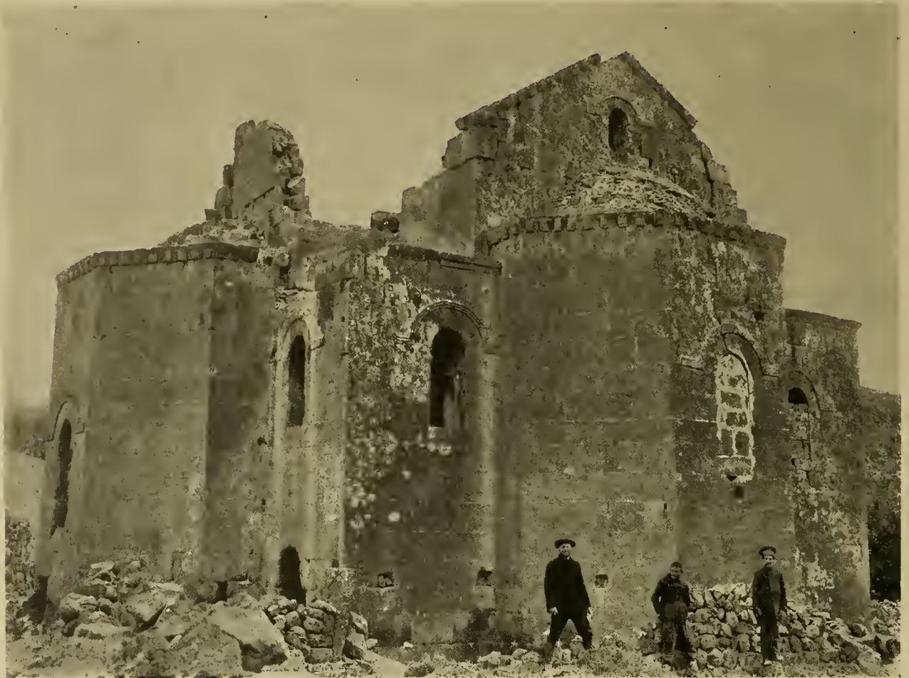
Abb. 85. Bagaran, Kathedrale: Ansicht von Nordosten.
