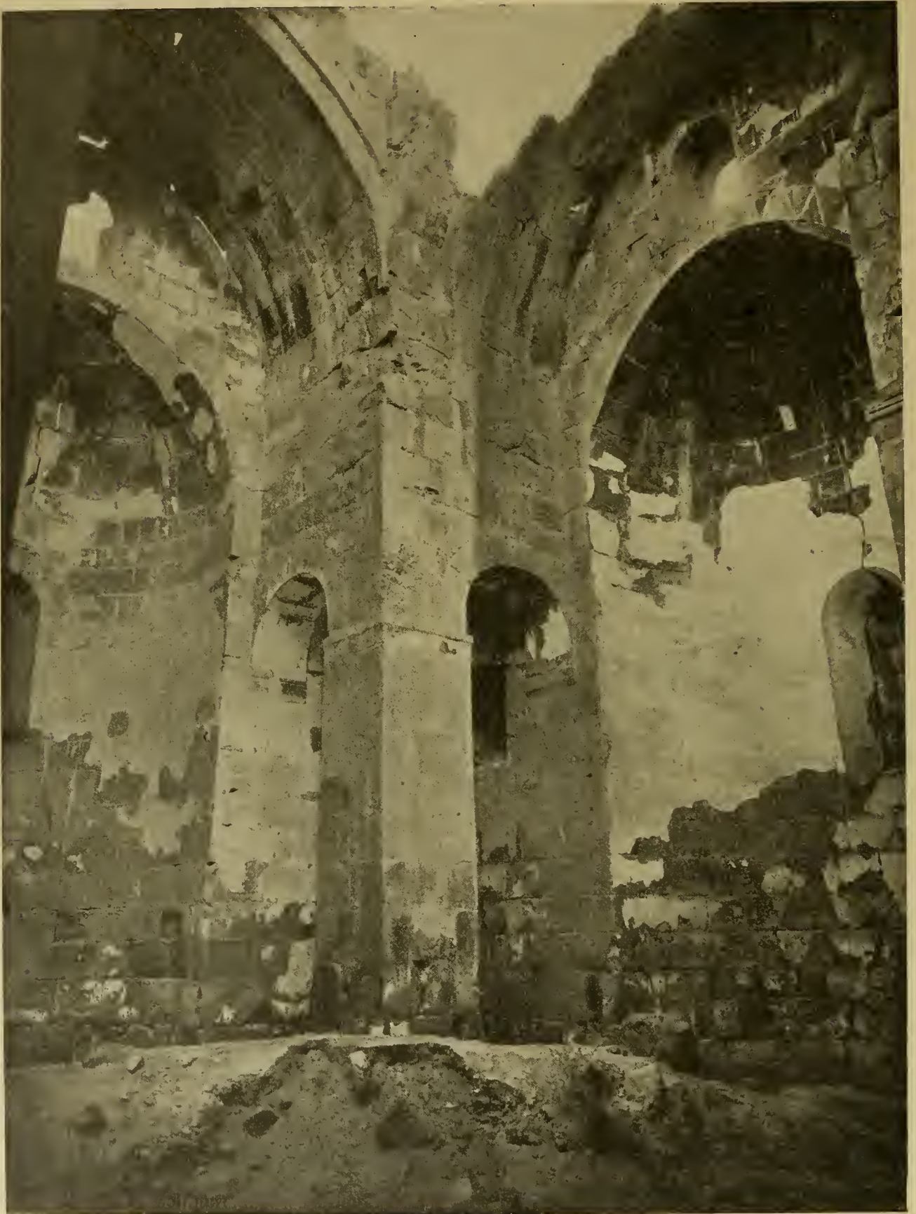
Abb. 255. Bagaran, Kathedrale: Nordwestpfeiler.
