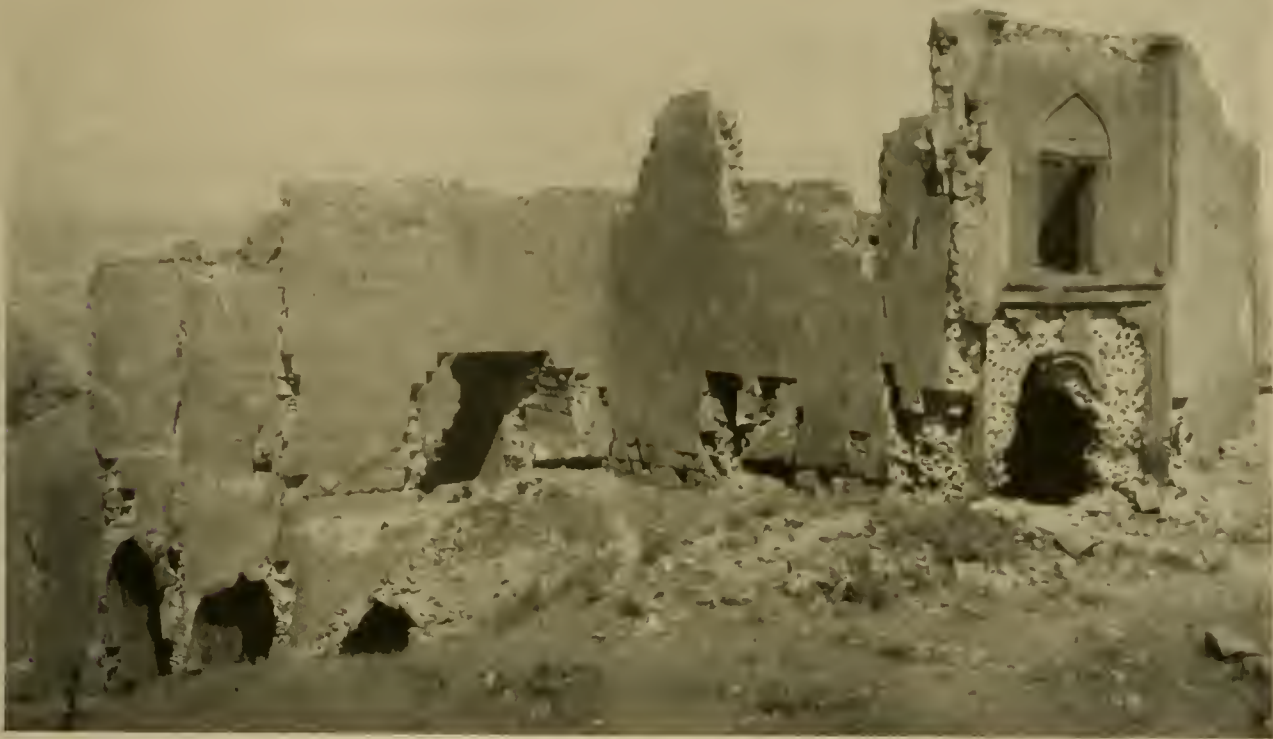
Abb. 308. Ani, Nordpalast: Ansicht von Südosten.
