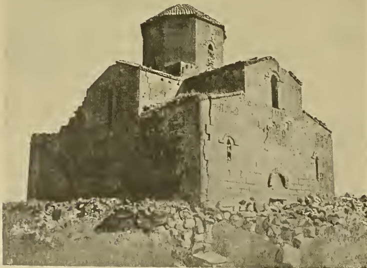
Abb. 217. Mren, Kathedrale: Ansicht von Nordwesten.
