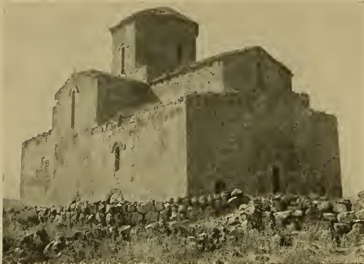
Abb. 215. Mren, Kathedrale: Ansicht von Südosten.
