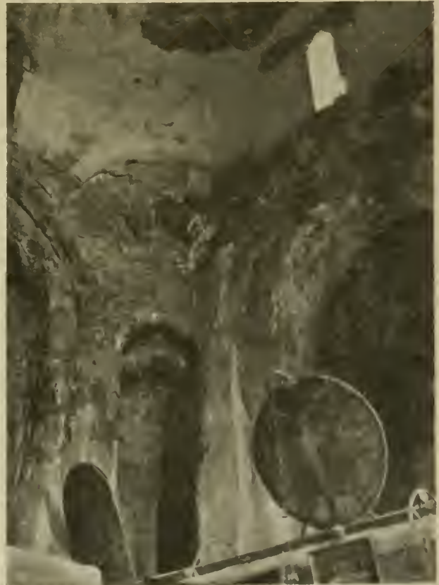
Abb. 70. Mzchet, Kreuzkirche: Trichternische in der Nordost-ecke des Grundquadrates.
