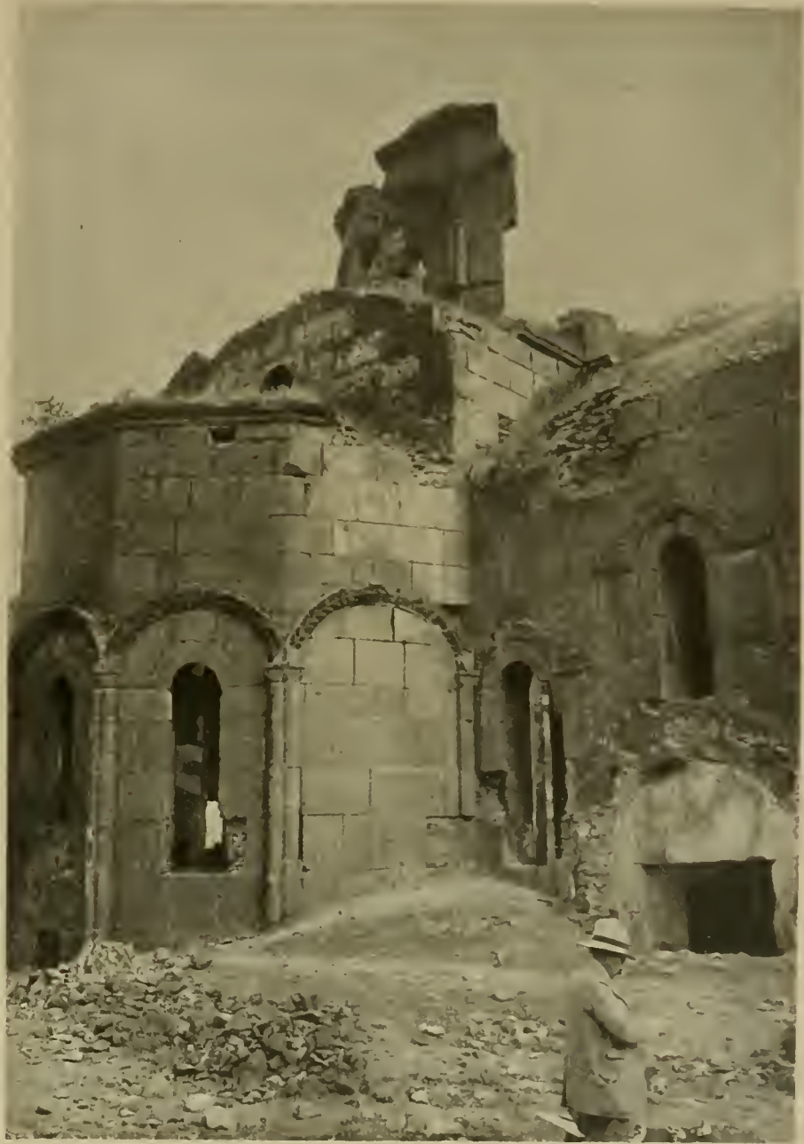
Abb. 16. Thalín, Dreischiffiger Dreipaß: Nordwestansicht einer Strebenische mit Blendbogen.
