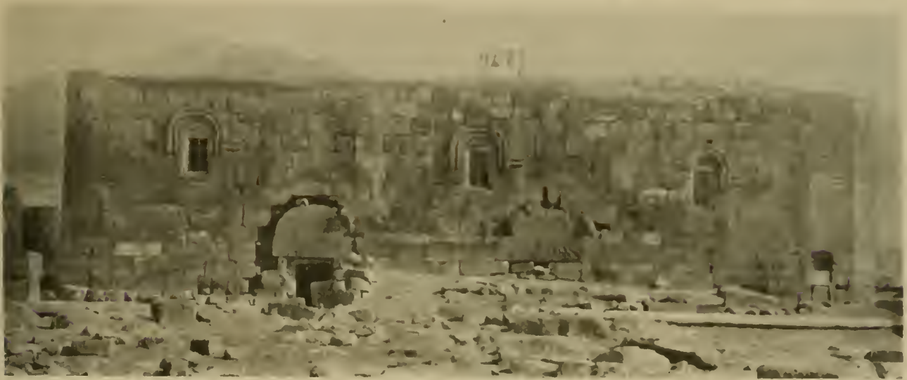
Abb. 173. Kassach, Dreischiffige Hallenkirche: Südansicht.
