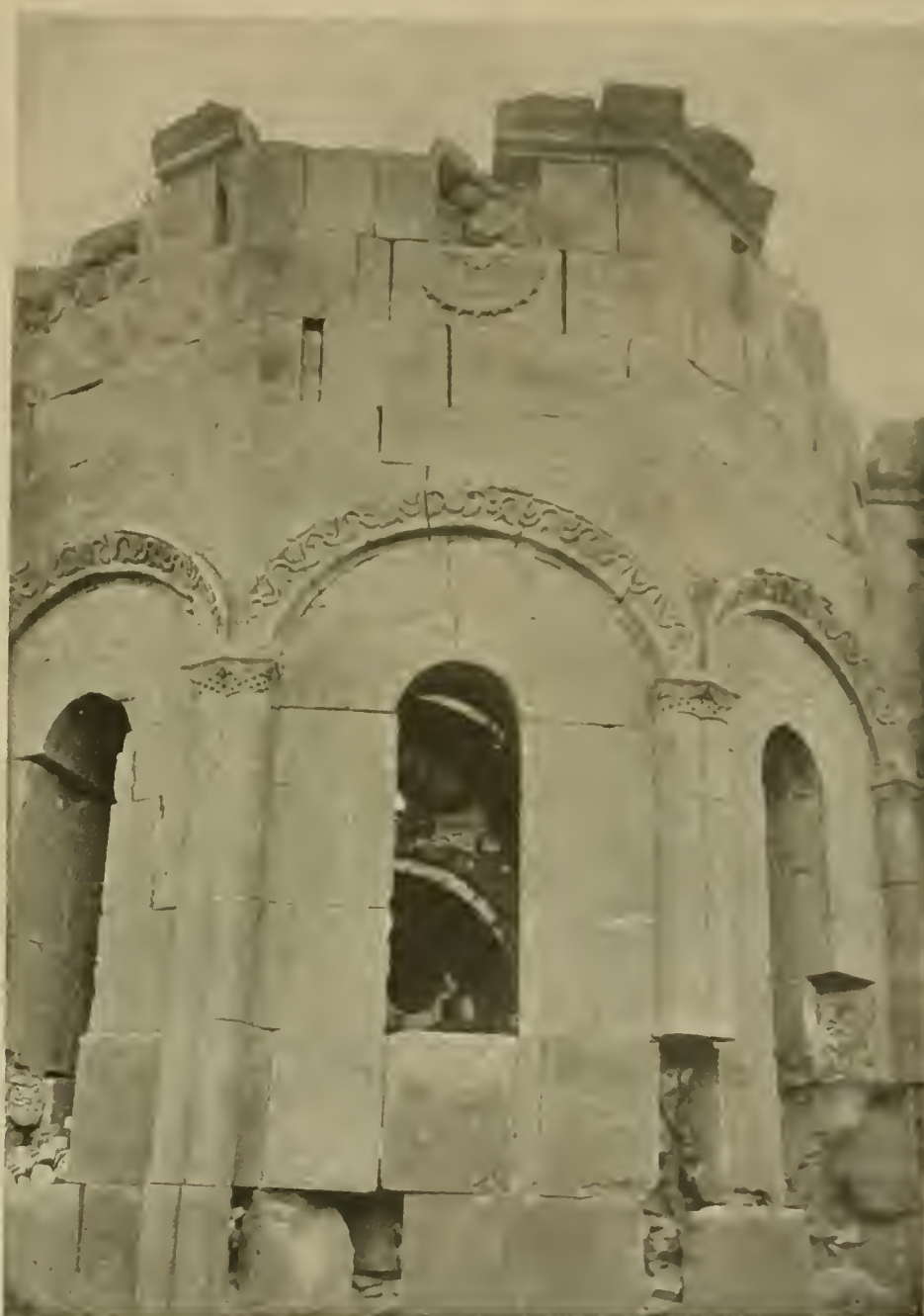
Abb. 202. Thalin, Kathedrale: Strebenische der Südseite.
