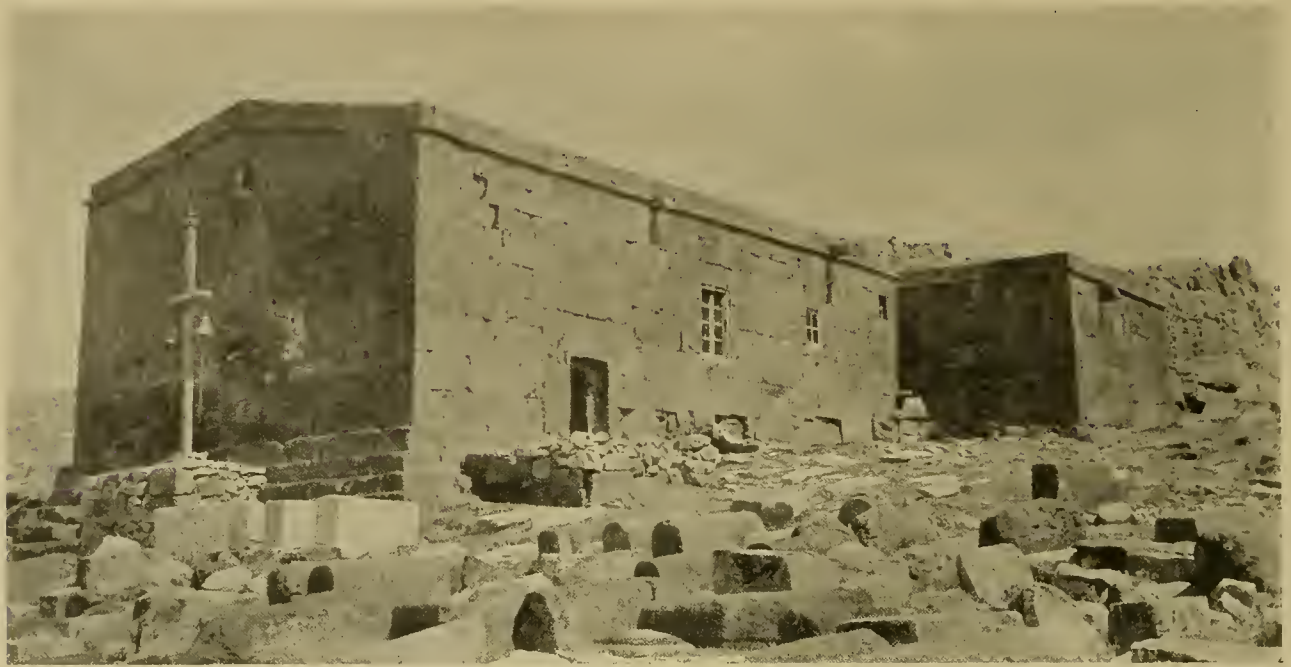
Abb. 151. Diraklar, Kirche: Südwestansicht.
