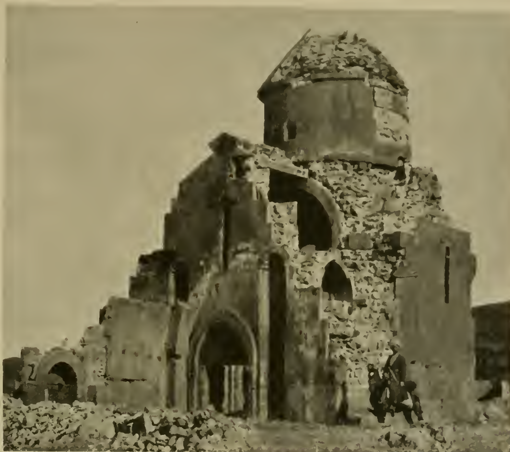
Abb. 239. Makarawank, Kirche: Südwestansicht.
