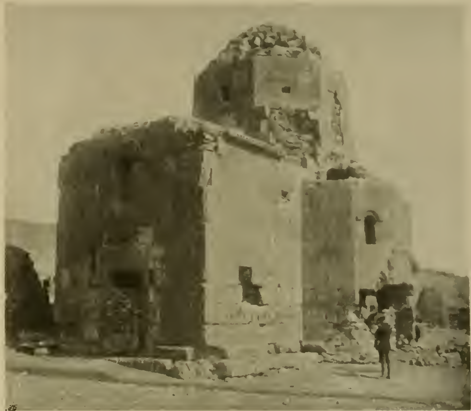
Abb. 187. Alaman, Ananiaskirche: Ansicht von Südwesten.
