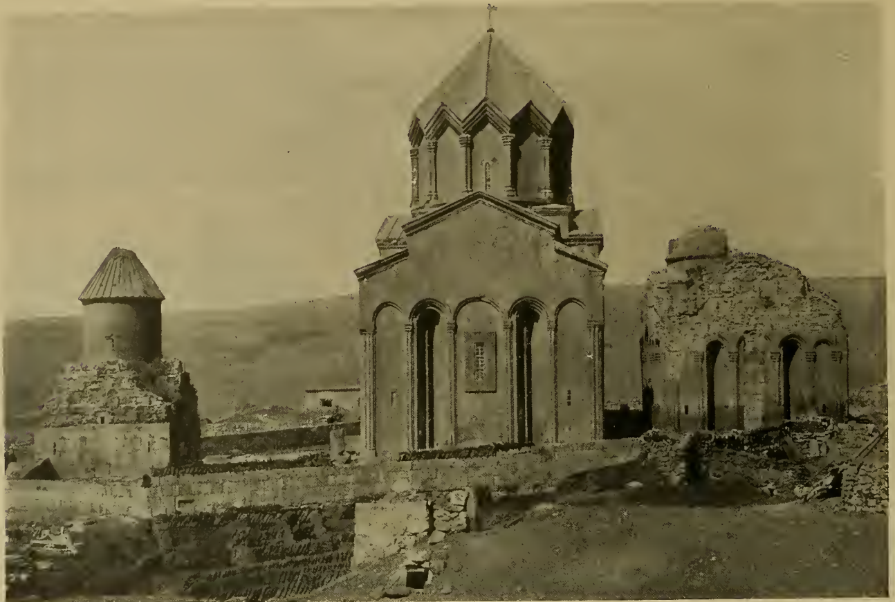
Abb. 7. Marmaschen, Hauptkirche mit den beiden Seitengebäuden: Ansicht von Osten. Aufnahme Thoramania.
