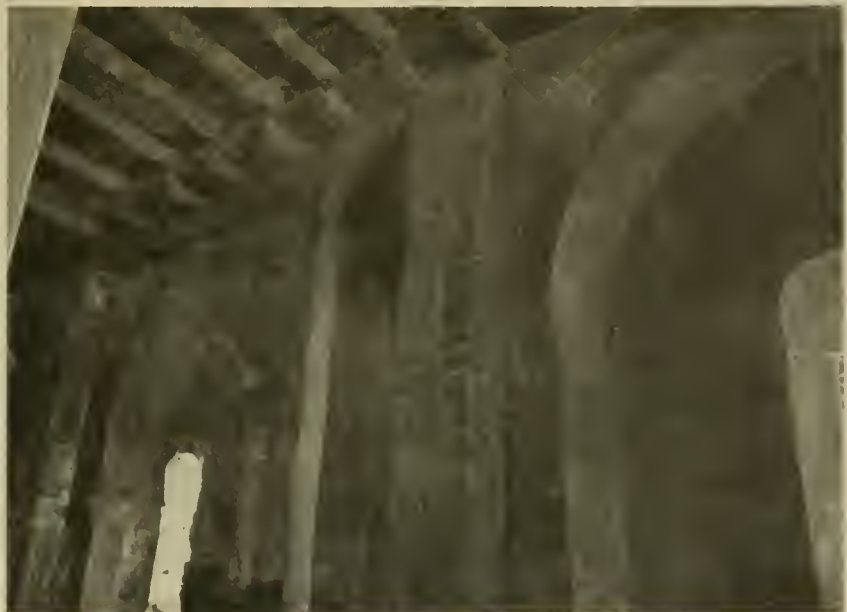
Abb. 170. Kassach. Dreischiffige Hallenkirche: Pfeiler des Hauptschiffes und südliches Seitenschiff.
