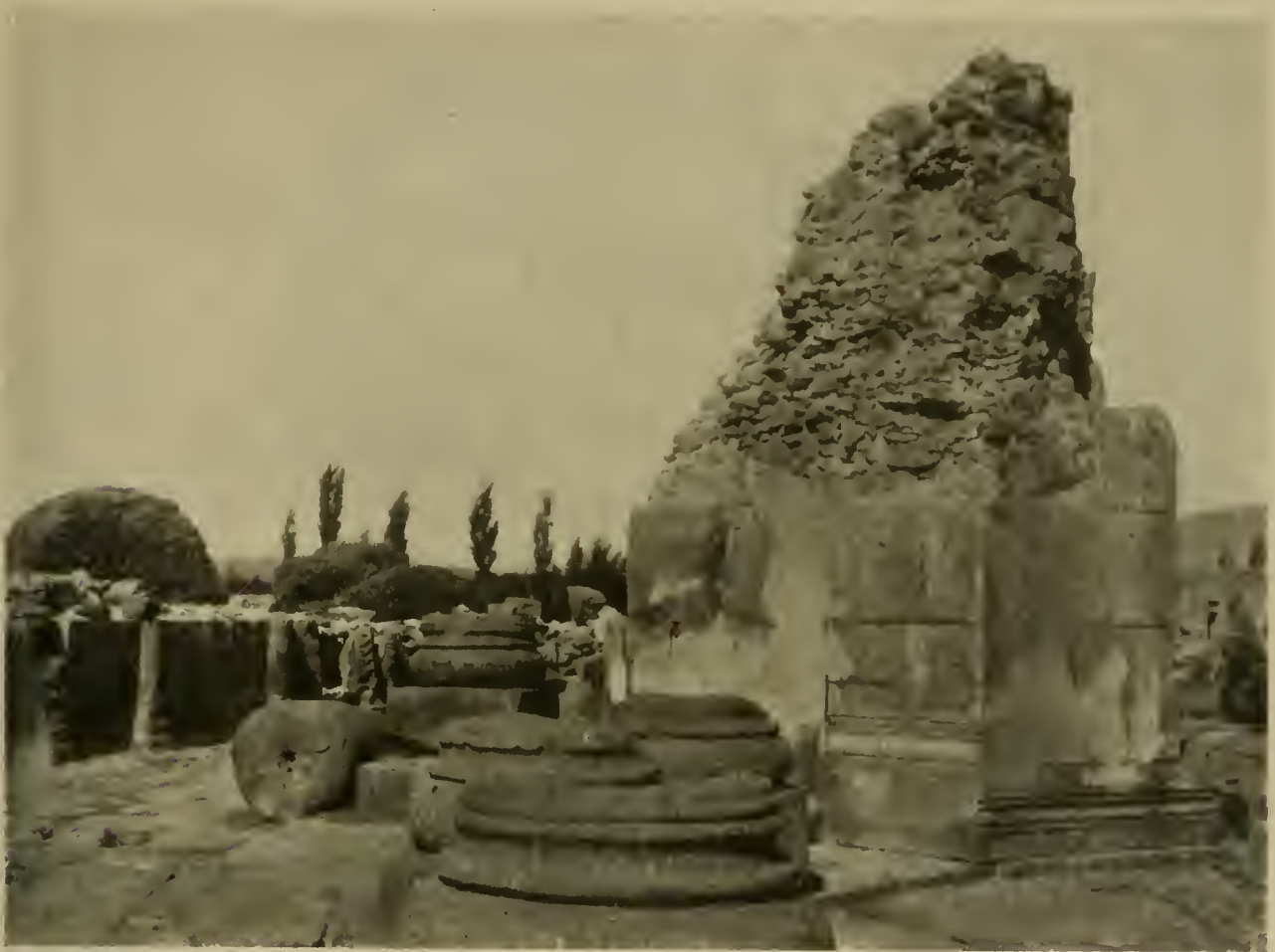
Abb. 110. Zwarthnotz, Palastkirche: Südwestpfeiler von der Südseite.
