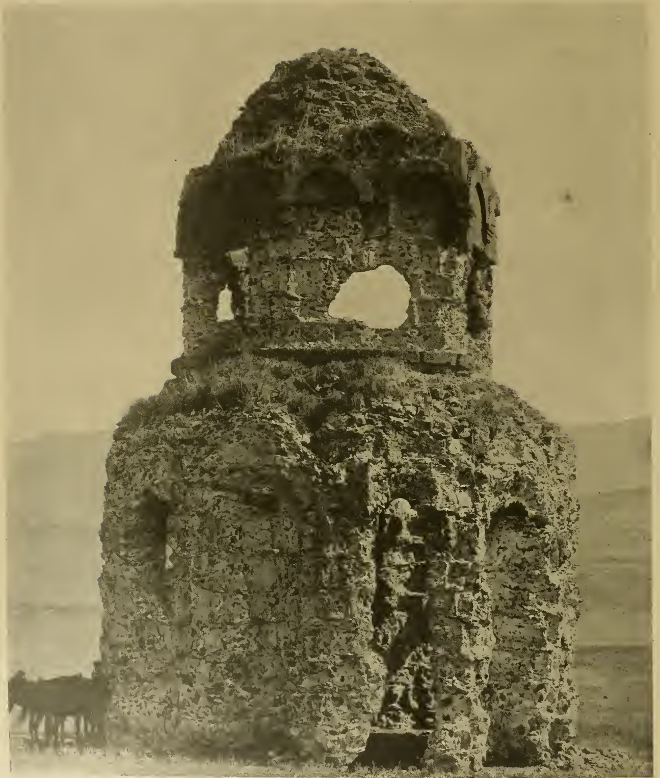
Abb. 1. Goguba, Sechspaßkirche: Gußmauerwerk, der Platten beraubt.
