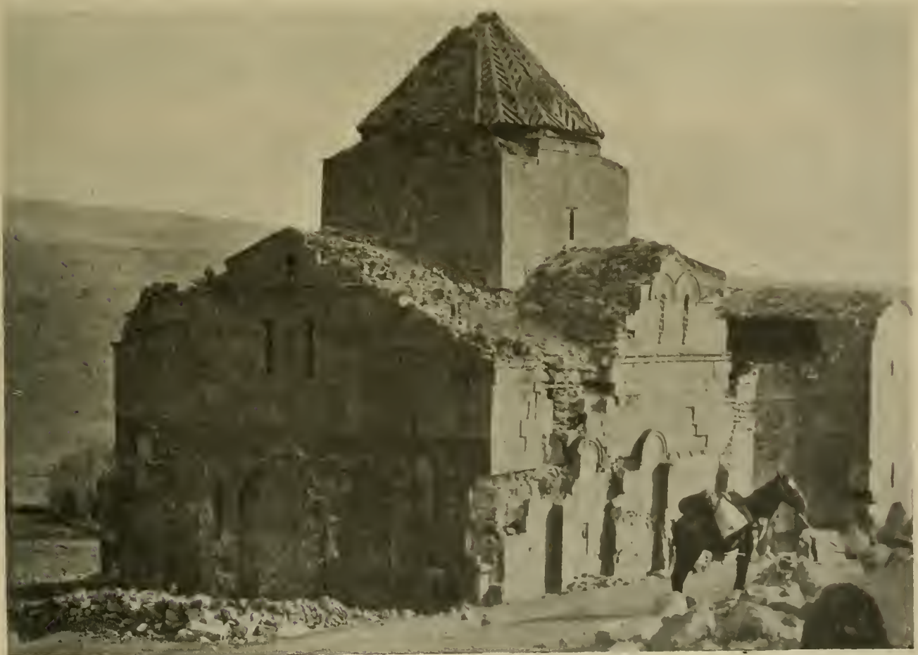
Abb. 24. Tekor, Sargiskirche: Ansicht von Südwesten vor dem Kuppelsturz.
