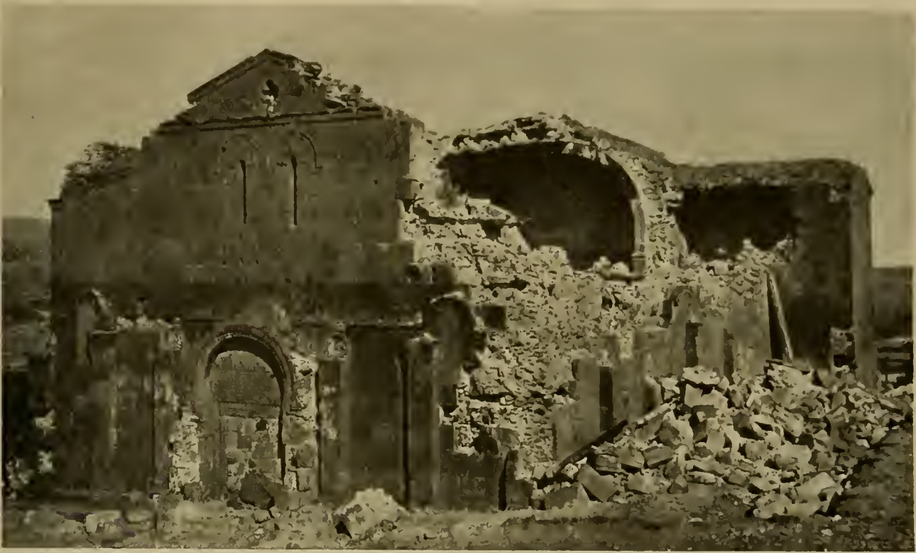
Abb. 382. Tekor, Sargiskirche, Südwestansicht: Heutiger Zustand (vgl. Abb. 24).
