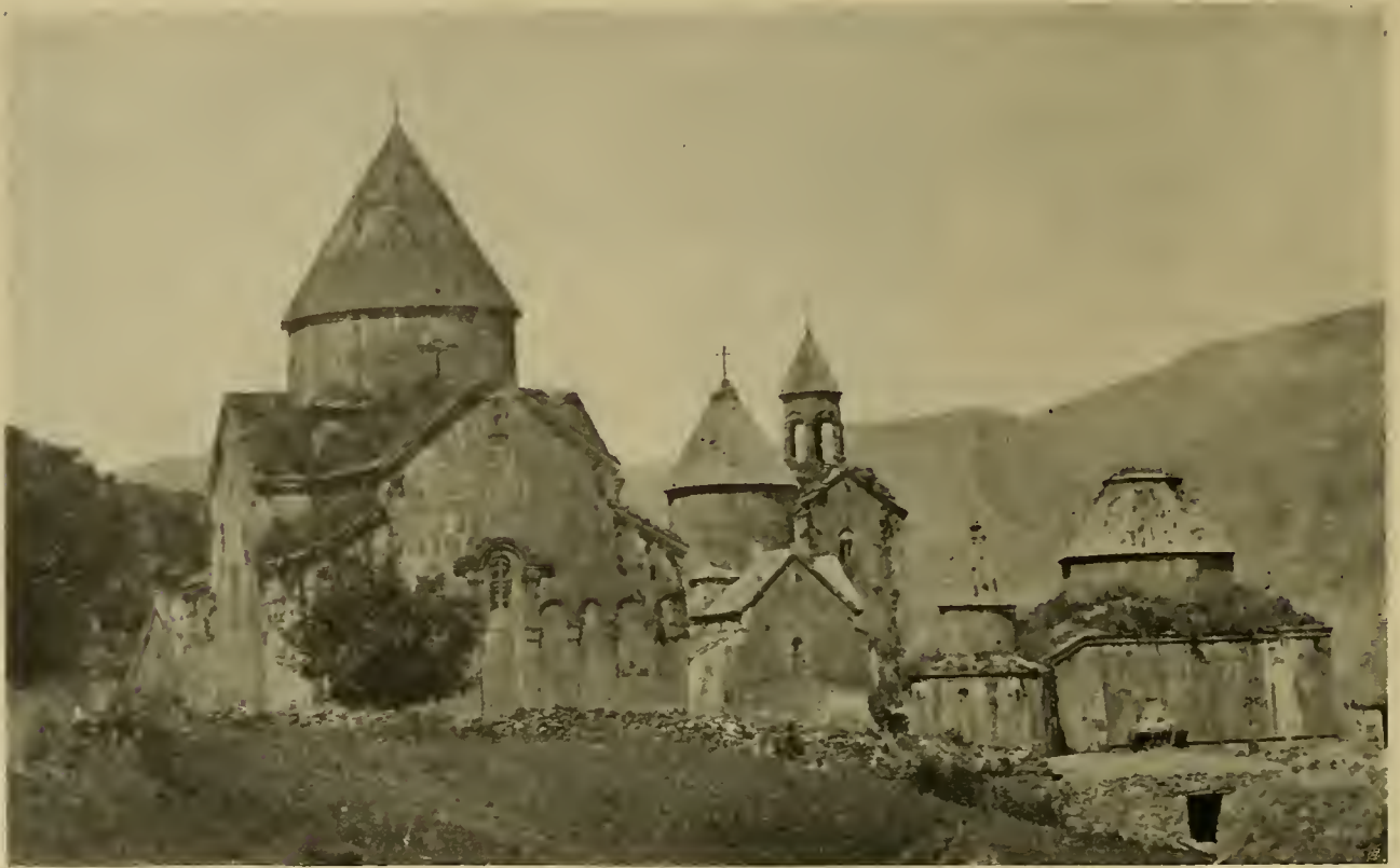
Abb. 90. Sanahin, Hauptgebäude des Klosters, von der Ost-(Rück-)seite gesehen. Aufnahme Nahapetian.
