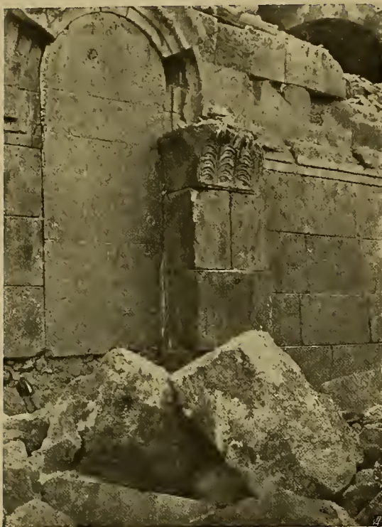
Abb. 365. Tekor, Sargiskirche: Vermauerte Südtür.
