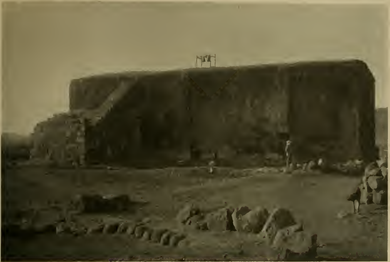
Abb. 8. Kassach, Längsgerichtete Tonnenkirche: Ansicht von Norden.
