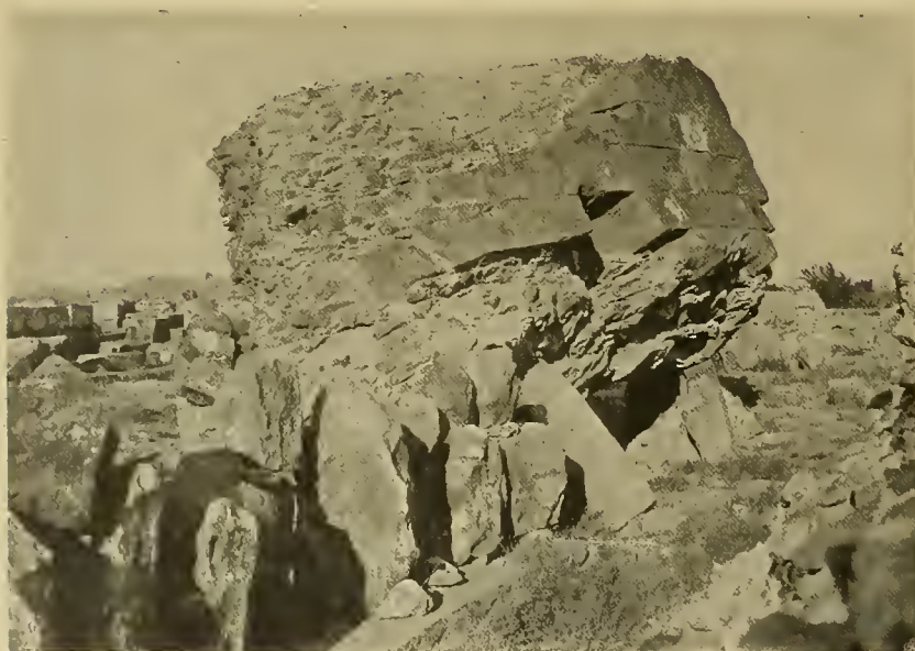
Abb. 247. Zwarthnotz, Gregorkirche: Mauerbrocken von der Wölbung.
