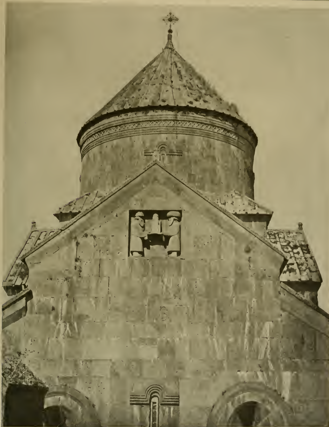
Abb. 349. Hagbat, Hauptkirche: Dachansicht von Osten her.
