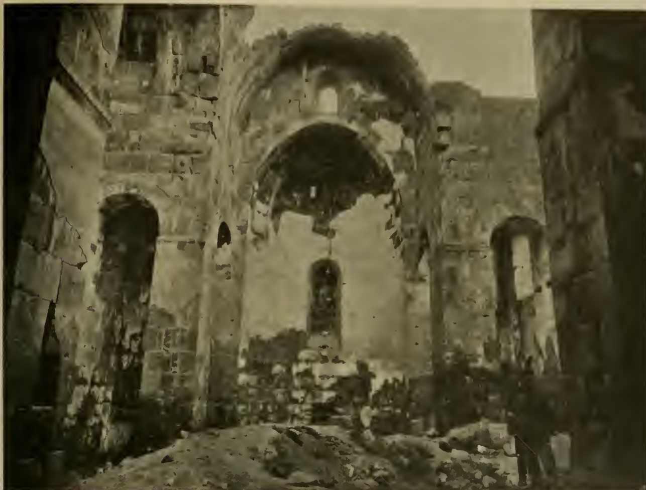
Abb. 28. Bagaran, Kathedrale: Innenansicht der Strebenische im Norden.
