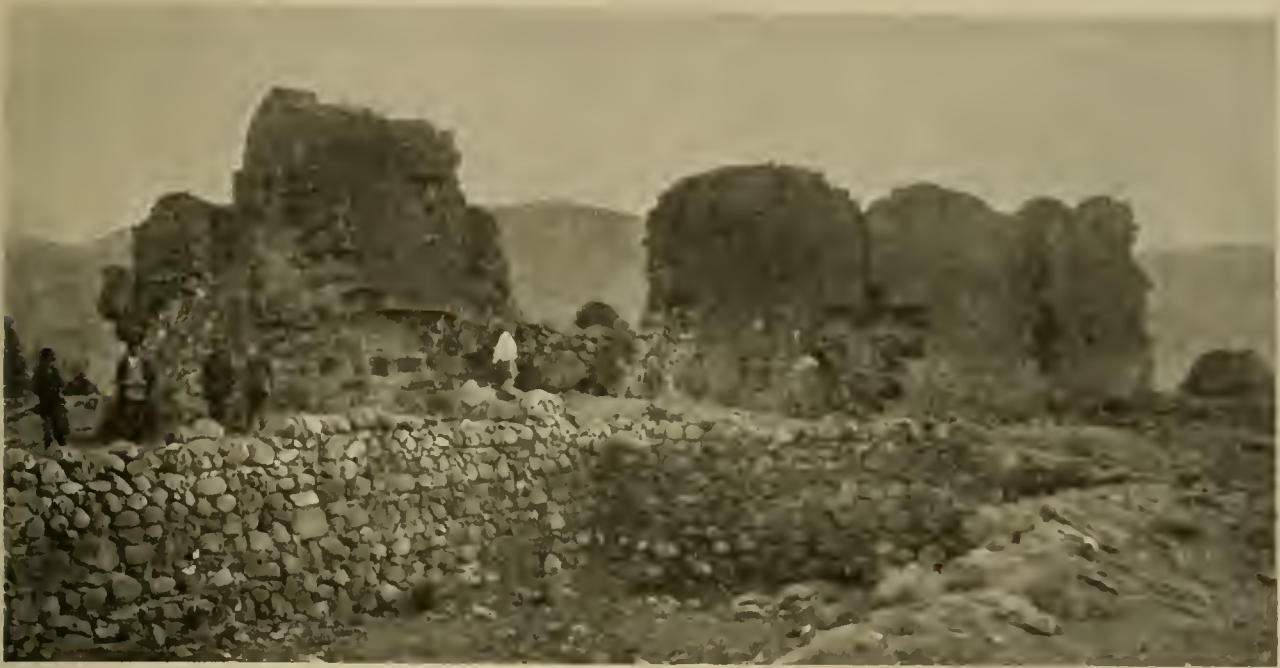
Abb. 160. Garni, Kirche: Außenansicht von Nordosten her.
