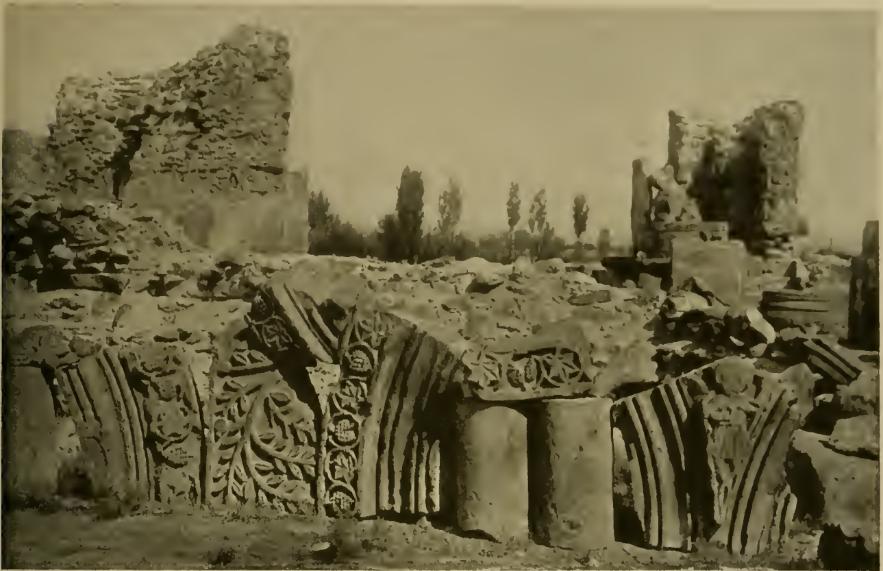
Abb. 458. Zwarthnotz, Gregorkirche: Reste der Ausstattung im Westausgang zusammengestellt (Fortsetzung).
