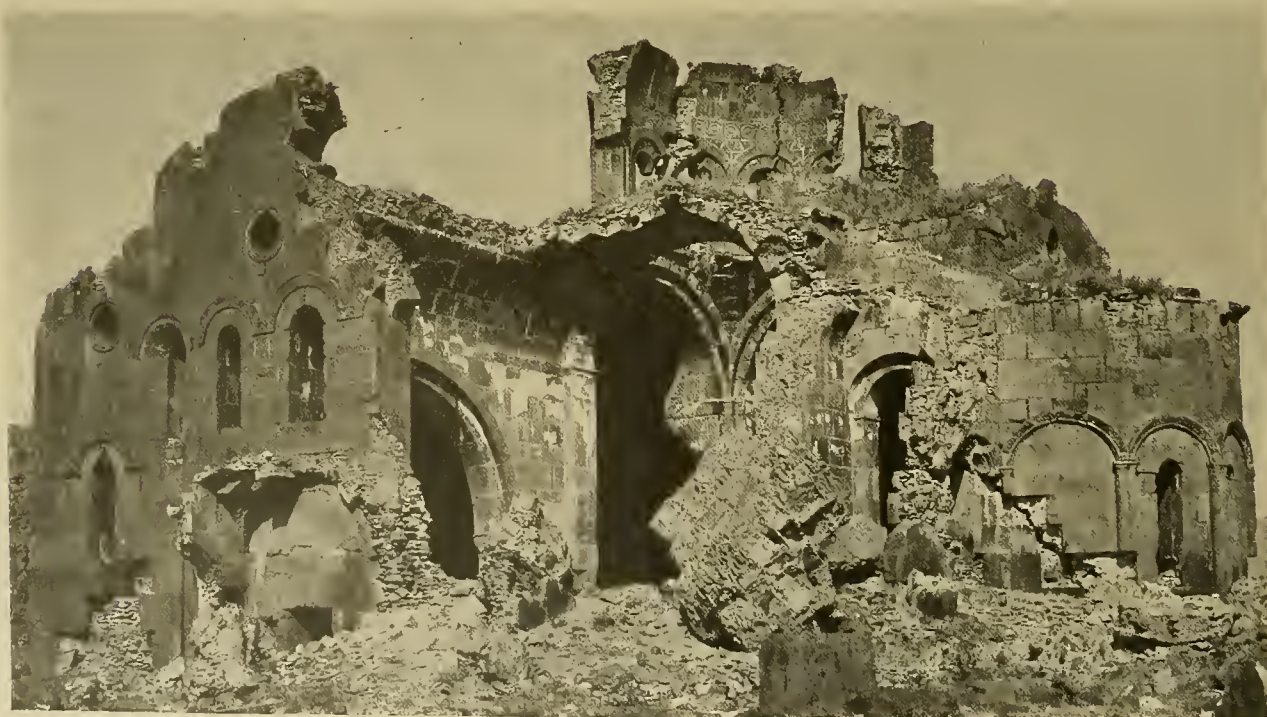
Abb. 199. Thalin, Kathedrale: Ansicht von Südwesten.
