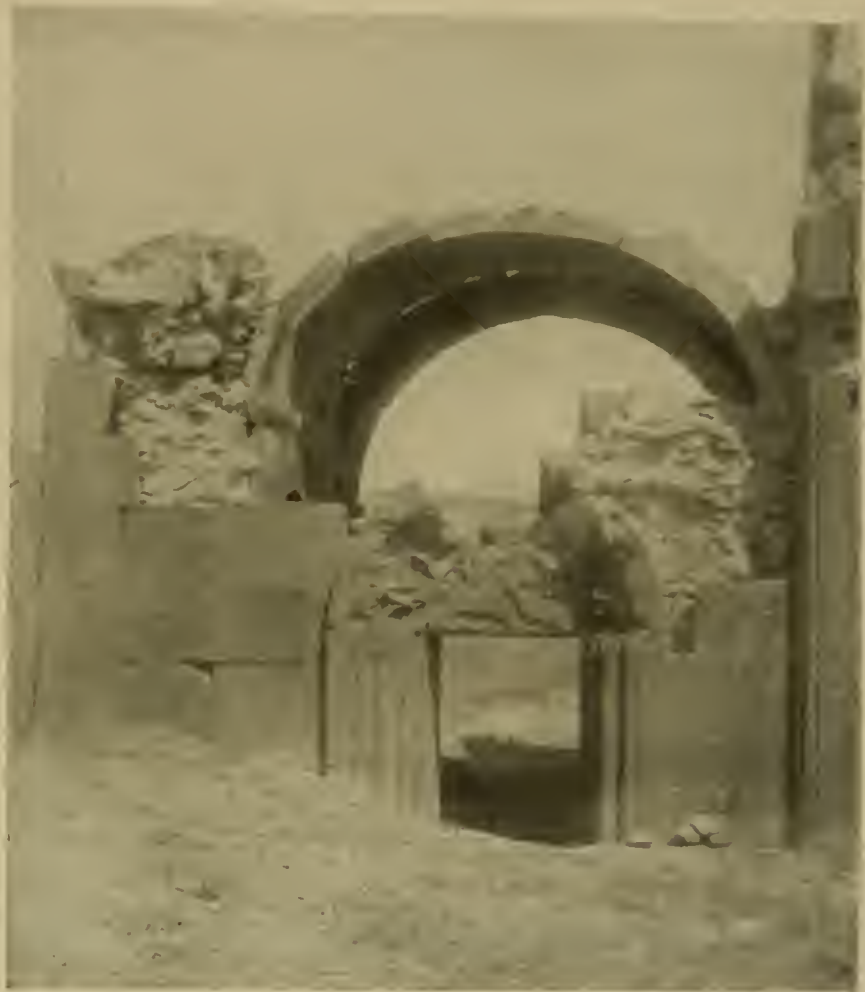
Abb. 254. Karawank, Streberaum der Kirche: Art des Wölbens. Aufnahme Jermakov.
