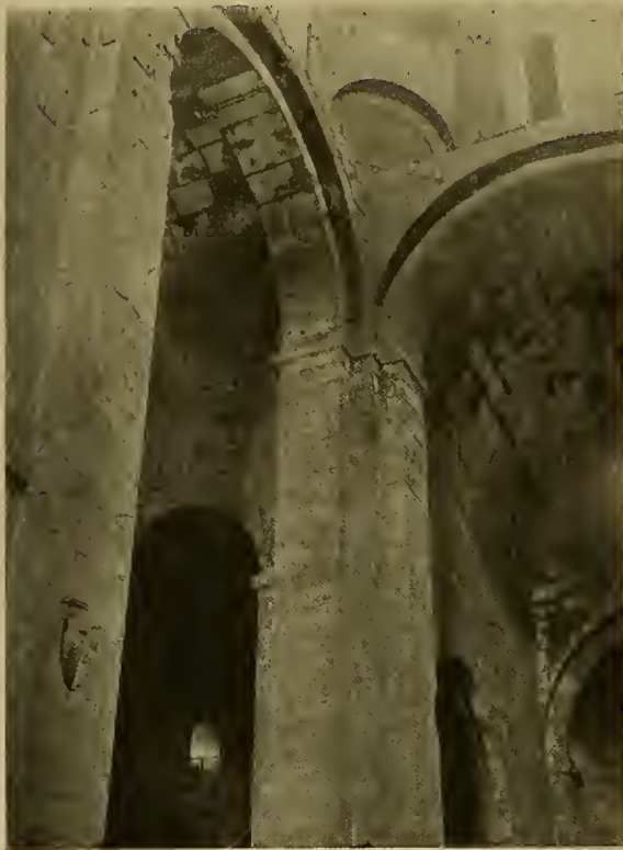
Abb. 344. Mren, Kathedrale: Kuppelpfeiler.
