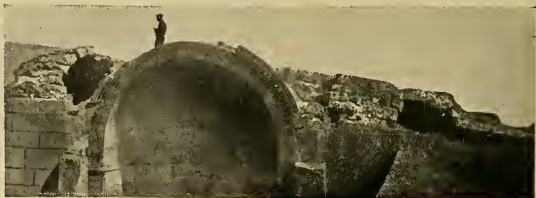
Abb. 427. Ereruk, Basilika: Steigende Tonnen der östlichen Seitenräume.
