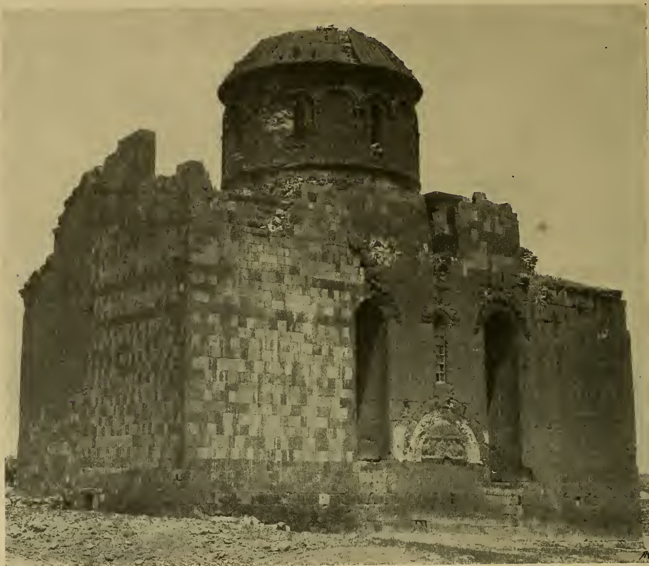
Abb. 253. Ughuzlü, Kirche: Der alte Bau deutlich von den Ergänzungen zu unterscheiden. Aufnahme Thoramanian.
