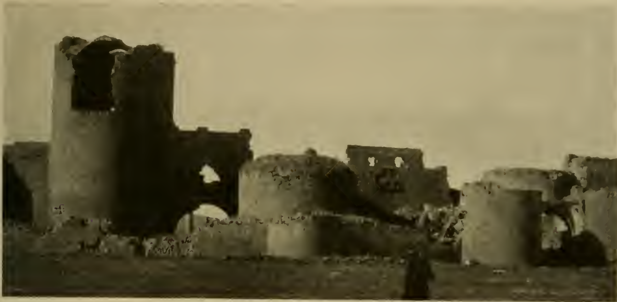
Abb. 313. Ani, Landmauern: Haupttort von außen.
