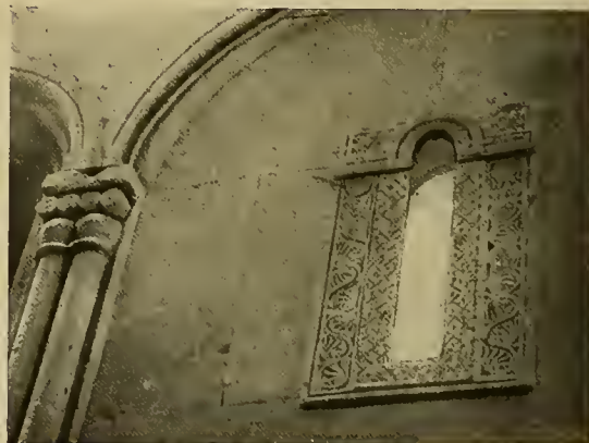
Abb. 367. Marmaschen, Nordbau: Blendbogen und Fenster der Südwand.
