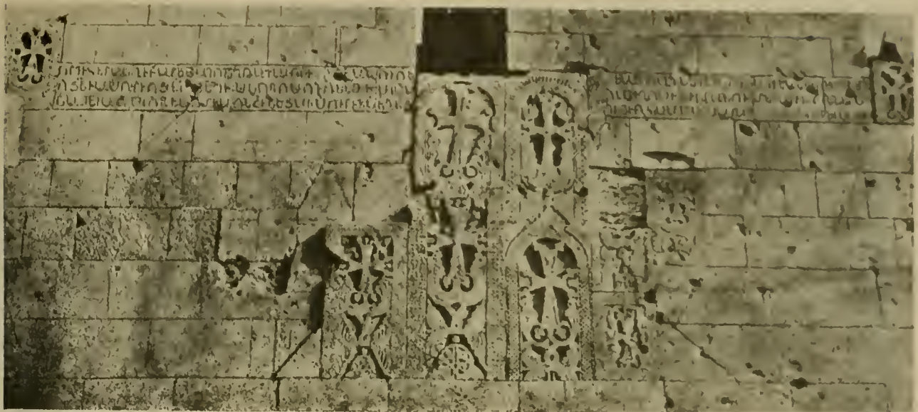
Abb. 38: Mren, Kathedrale: Bauinschrift der Westseite.
