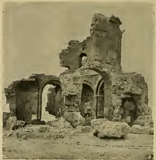
Abb. 140. Irind, Kirche: Ansicht von Südosten.
