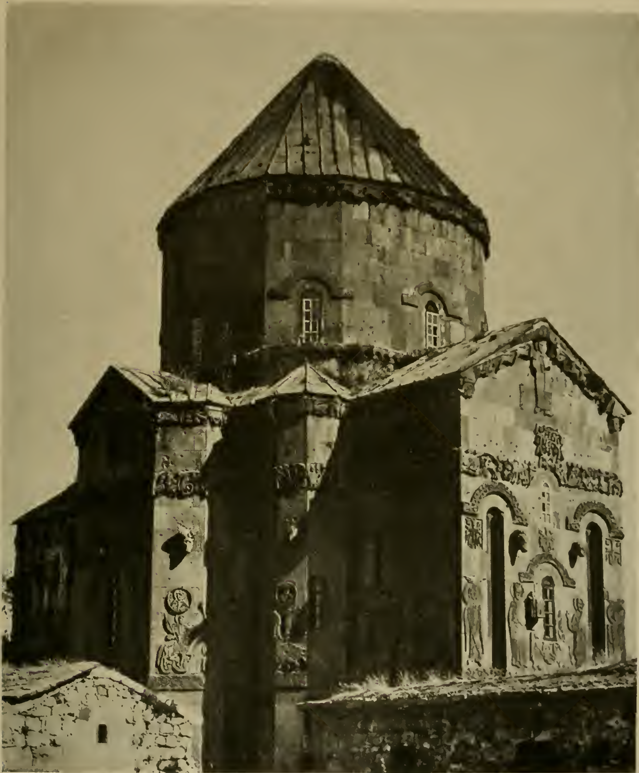
Abb. 330. Achthamar, Kreuzkirche: Nordwestansicht.
